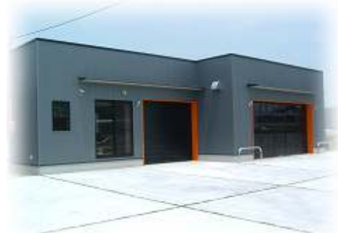
クルマ用の主要開口部は、開閉性能が良いコマーシャルTYPEのオーバースライダー
