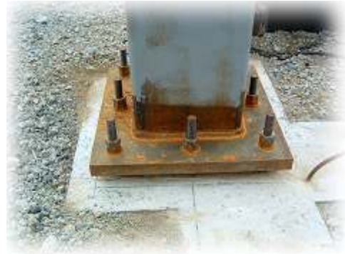
精度の高さからスイング式アンカーボルトと柱脚のベースプレートはピッタリと接合！
